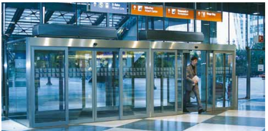
Portes anti-fumée, hall d'entrée, MUC
